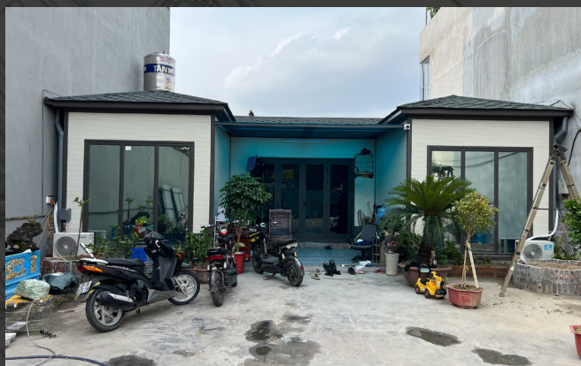
NHÀ THI CÔNG 50M 2 - SÓC SƠN
