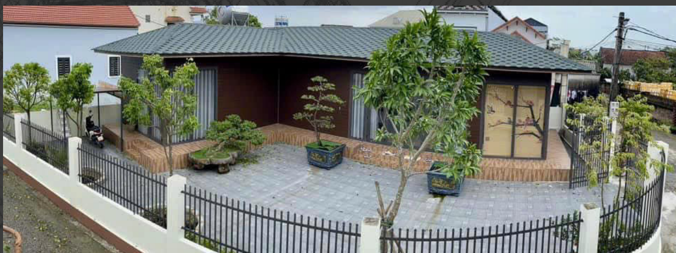
HOÀN THIỆN THI CÔNG NHÀ 80M 2 - QUẢNG NINH
