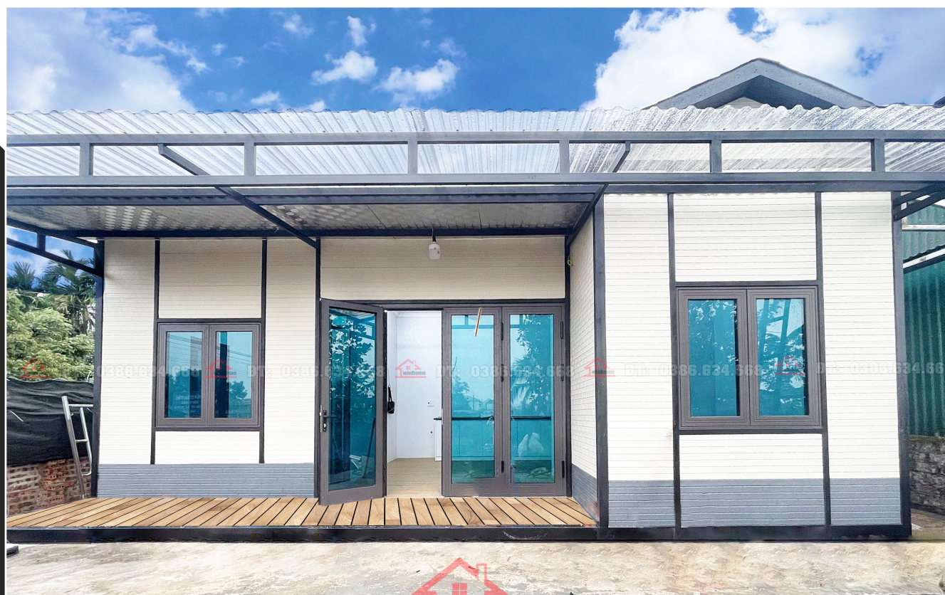
NHÀ LẮP GHÉP 40M 2 TẠI QUẢNG NINH
